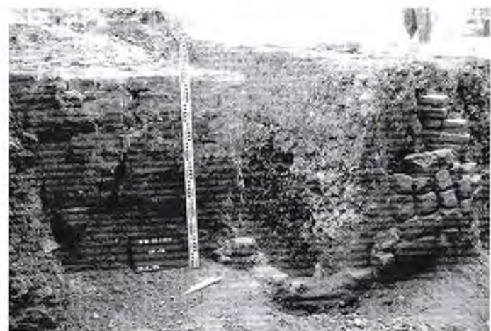
Abb. 5 Schürloch mit Stützmauer.
