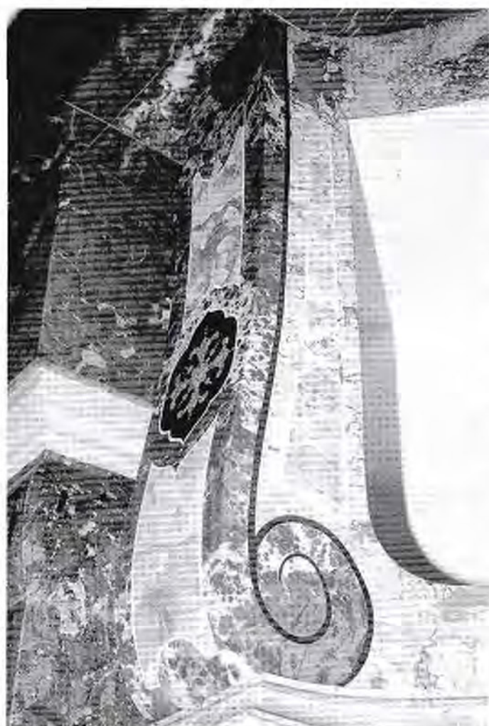
Die wiederhergestellte Stuckmarmorsäule.
