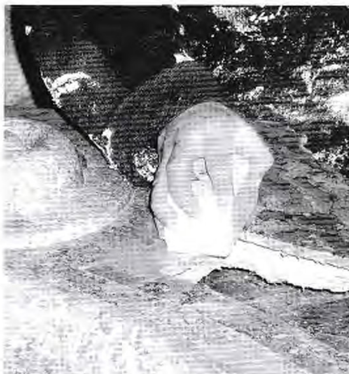
Der Stuckmarmor wird mit dem Schlangenstein poliert. Foto: Dr. Frank Kretzschmar
